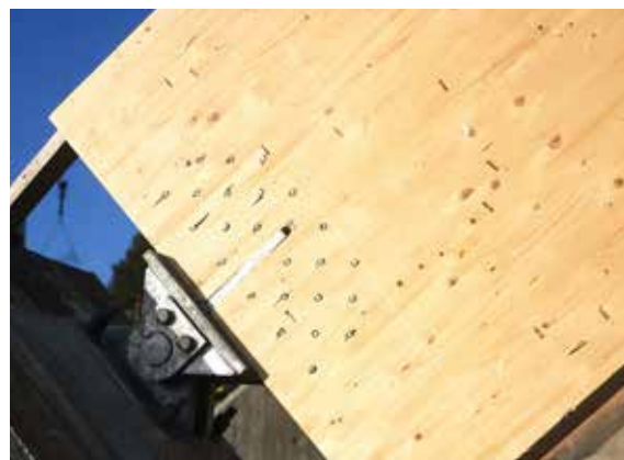
Exempel på båganfang med inslitsade stålplåtar och dymlingar av stål, Kolmårdens djurpark.
