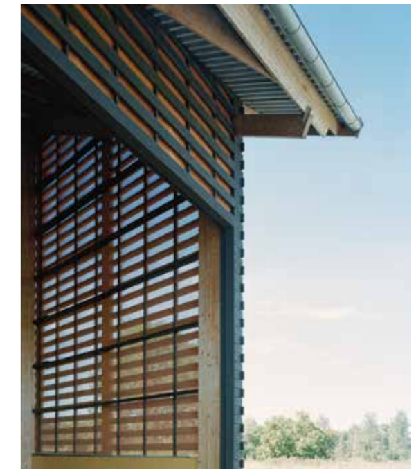
Ladugård med bärande konstruktion av limträ, Löhammar ladugård, nominerad till Träpriset 2008.
