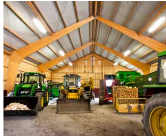
Maskinhall av treledsramar med fingerskarvade ramhörn, Söderköping.
